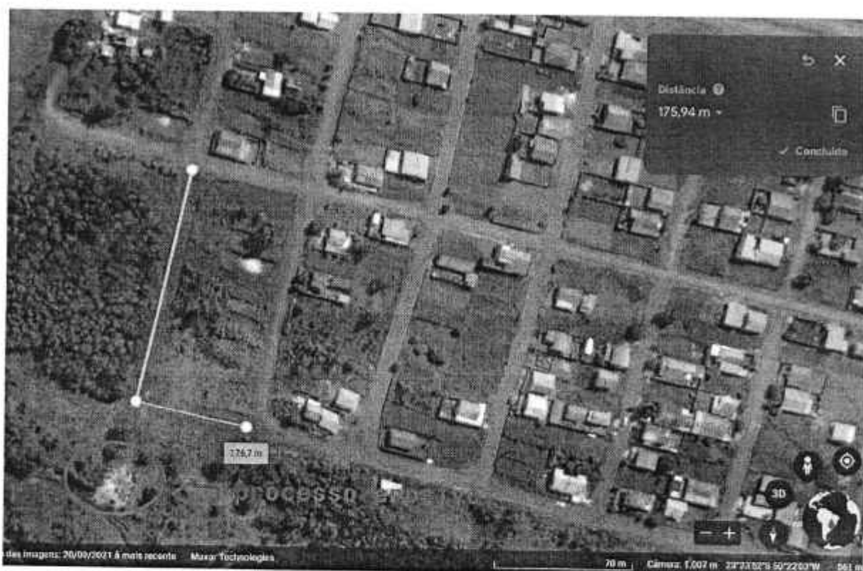
Figura 1 - Necessidade de abertura de ruas (trecho marcado), bem como execução de infraestrutura sob responsabilidade do Município, para viabilizar a conclusão dos serviços pactuados e a conclusão do contrato em questão. Destaque para processo erosivo, já nítido via satélite.
