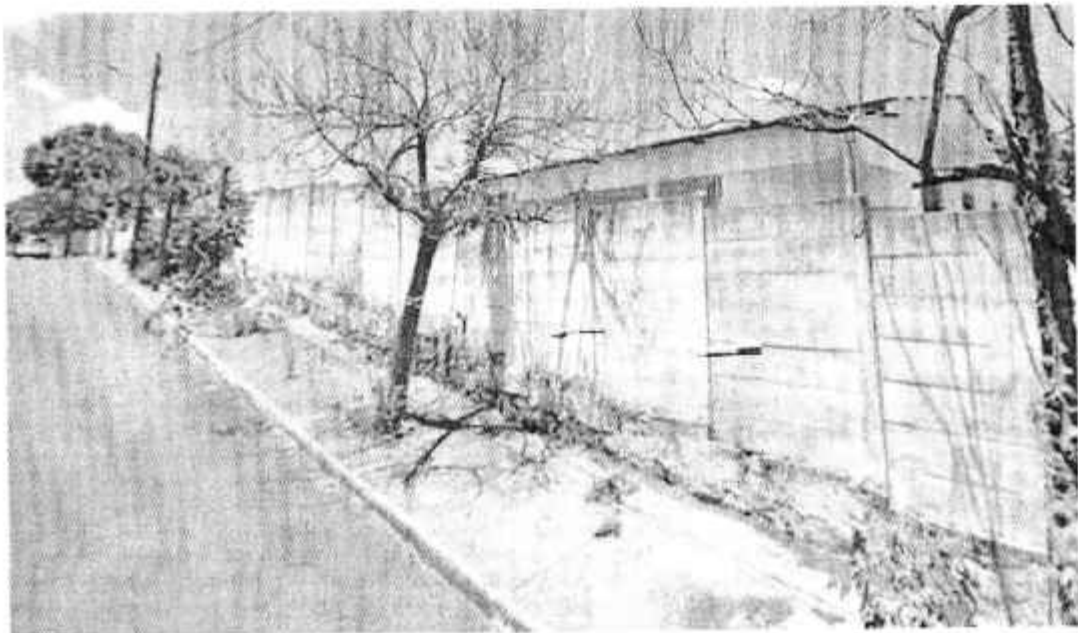
Figura 3 Vista frontal, com muro em placas à ser retirado e reutilizado
