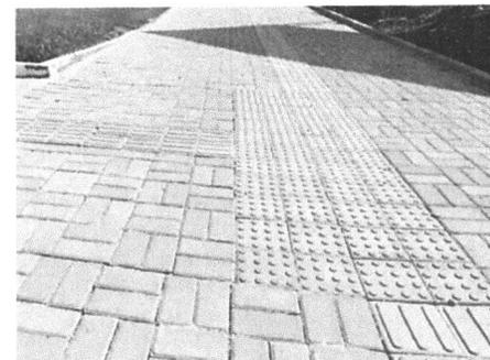
2.1.1.2 – Todos os pisos tipo “Paver” serão assentados conforme descrito, sendo reforçados com altura do piso h=6cm.
