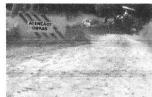
Fig. 5: Exemplo de sinalização de obras
