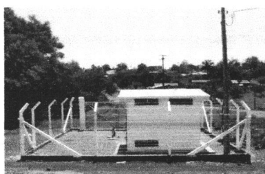
Fig. 22: Vista de urbanização (cerca e lona sobre pedrisco) e ventilação da casa de química
