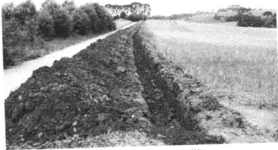
Fig. 6: Escavação de vala (1)
