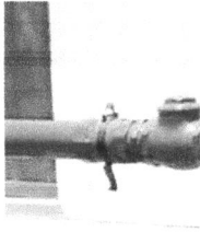
Fig. 26: Fixação de cabeçote de registro por meio de fita de autofusão
