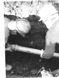
Fig. 10: Montagem de tubulação (detalhe: uso de EPI)
