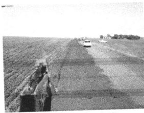
Fig. 7: Escavação de vala (2)
