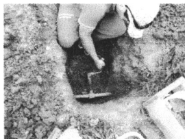
Fig. 14: Execução de ligação (1)
