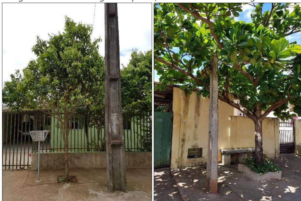
Figura 16 - Distância irregular do poste (R. Neuza M a e R. Hermenegildo Cavazani)
